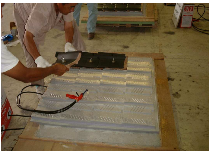
瓦を施工する
