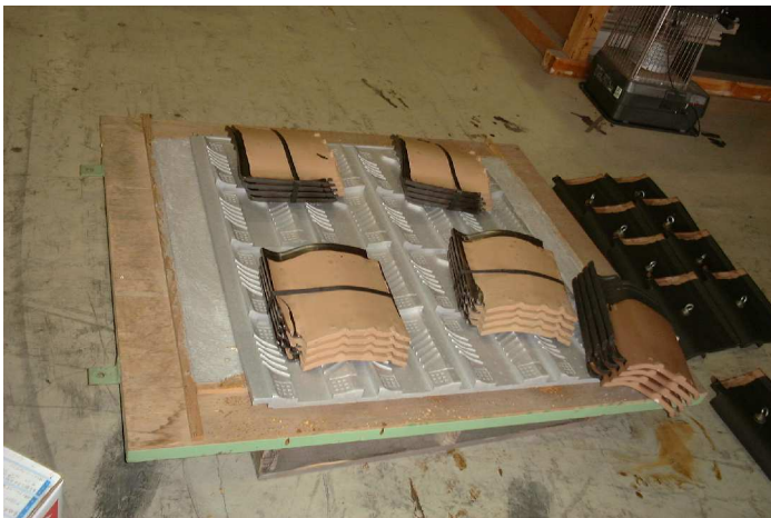
瓦を重しとして5分程載せる
