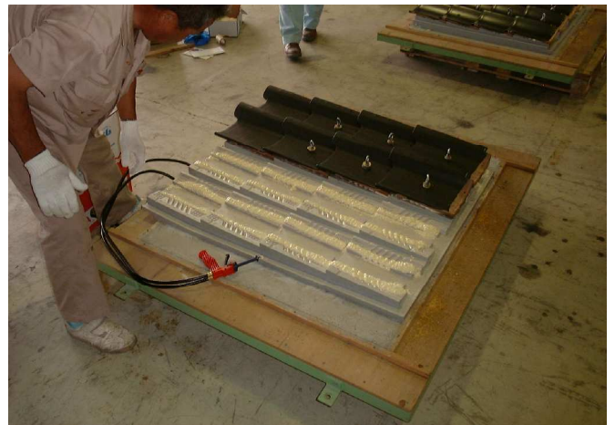
断熱ルーフの表面にポリフォームを吹く
