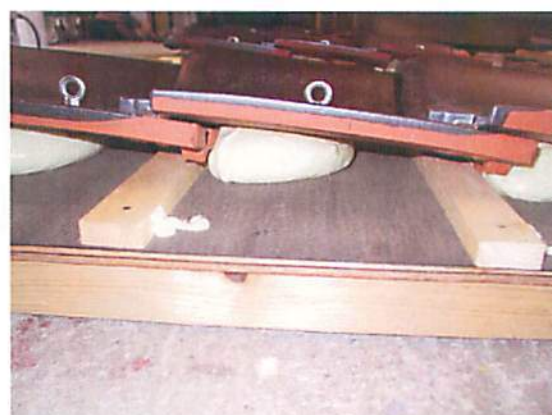
写真-4 J型粘土瓦改修施工状況
