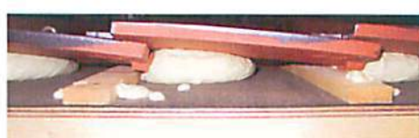
写真-8 J型粘土瓦(改修施工)
