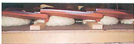
写真-5 J型粘土瓦(標準施工)
