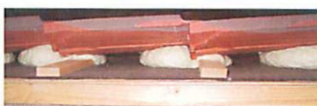
写真-6 S型粘土瓦(標準施工)
