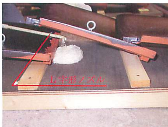
写真-3 J型粘土瓦改修施工状況
