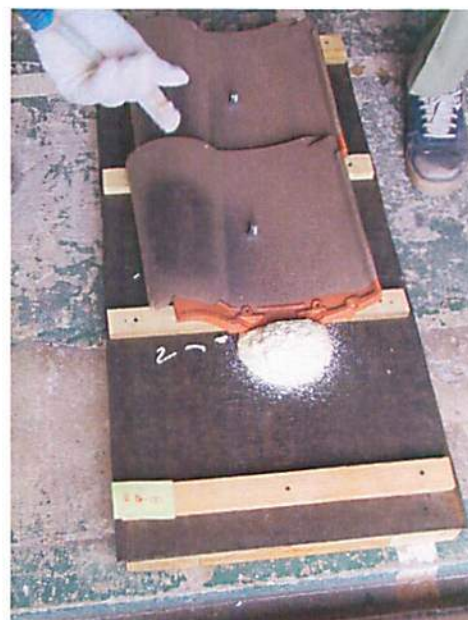
写真-2 S型粘土瓦標準施工状況
