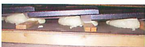
写真-7 J型セメント瓦(標準施工)
