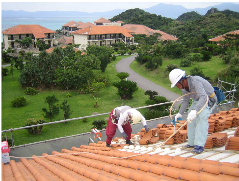
ポリフォームによる瓦の葺き直し状況
