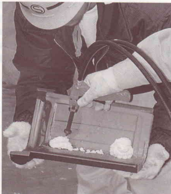
棟瓦の施工も銅線、ビス、土、モルタルなどを使用せず可能
