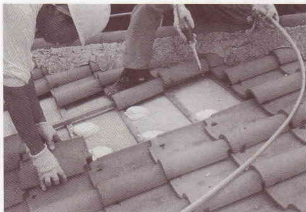
「ポリフォーム」の施工例。白漆喰瓦屋根が特長の沖縄で
