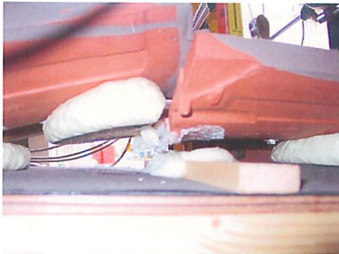
写真-15 破断状況(S型粘土瓦, No.3, 標準施工)
