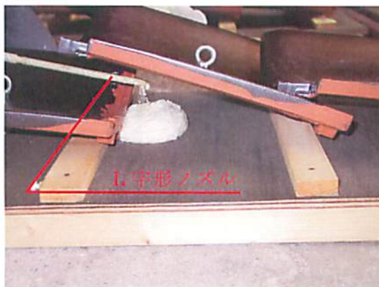
写真-3 J型粘土瓦改修施工状況
