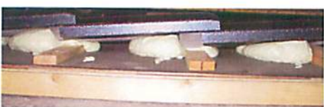
写真-7 J型セメント瓦(標準施工)
