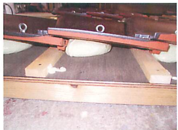
写真-4 J型粘土瓦改修施工状況
