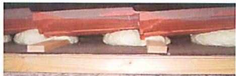
写真-6 S型粘土瓦(標準施工)
