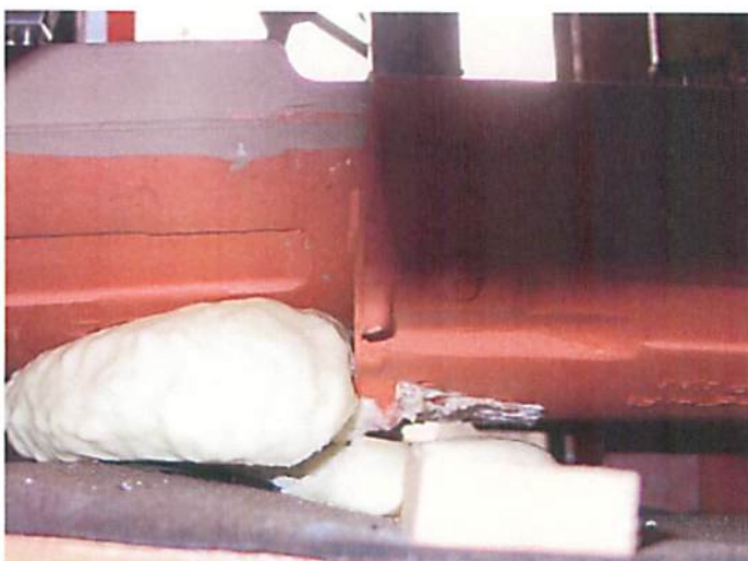
写真-14 破断状況(S型粘土瓦, No.2, 標準施工)
