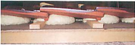
写真-5 J型粘土瓦(標準施工)
