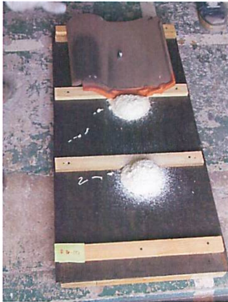
写真-1 S型粘土瓦標準施工状況
