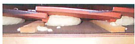
写真-8 J型粘土瓦(改修施工)
